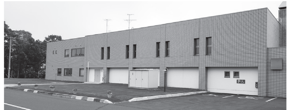
この芝生のところに災害時に必要な非常用発電機を設置。
