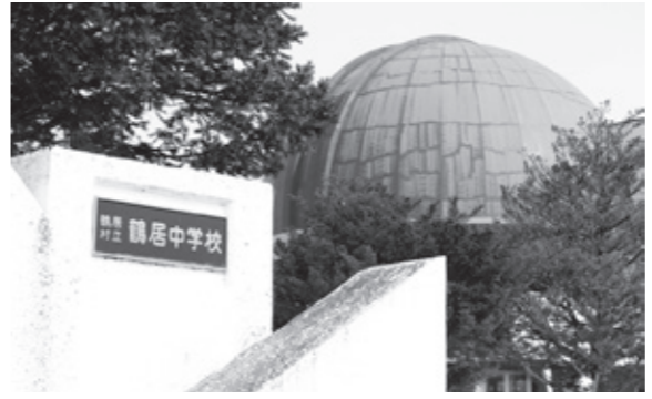
地中熱ヒートポンプにより冷房も
