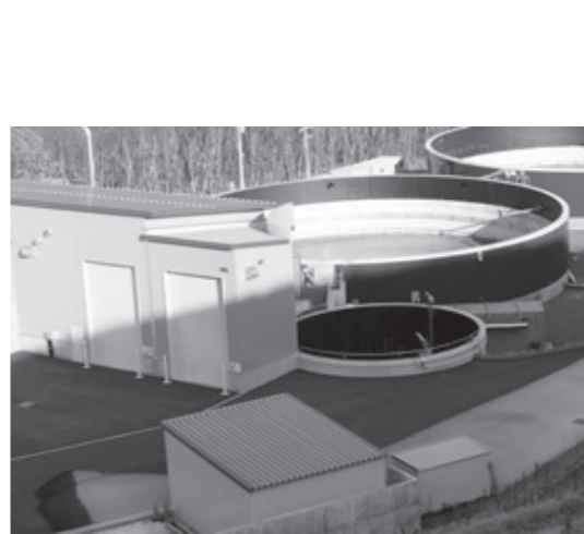
いつ動く？家畜糞尿バイオガスプラント
