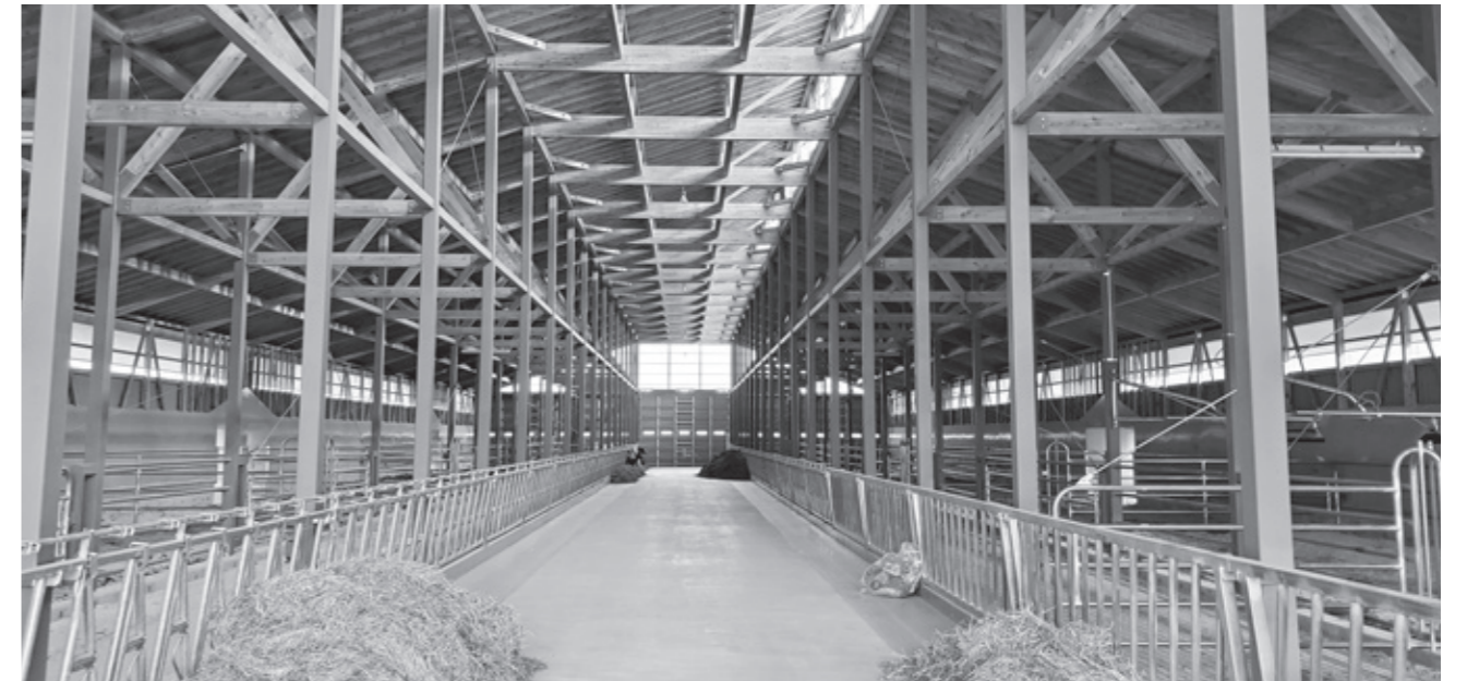
道産のカラマツ材をたくさん使用することでコストを削減しています。
