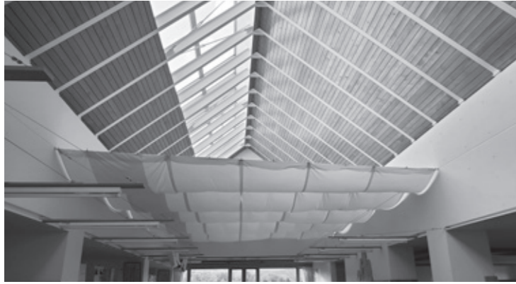
鶴居小学校の2階天窓からの直射日光を防ぐために遮光カーテンを設置
