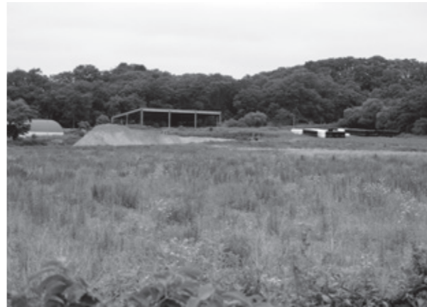
支幌呂に新設されるTMRセンター予定地
