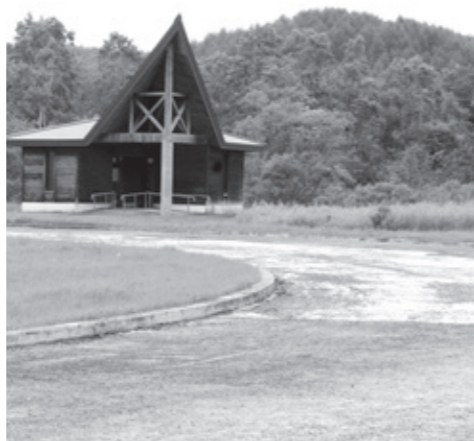
老朽化が進む幌呂スケートリンク
