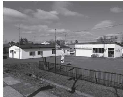
地域福祉拠点施設の建設予定地
