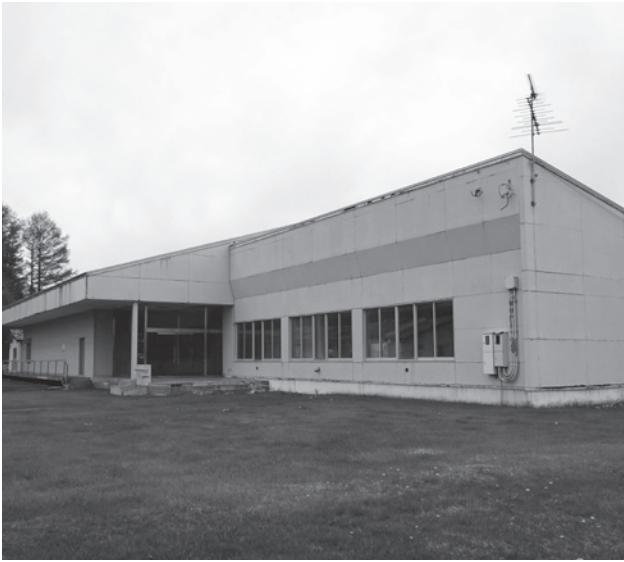
解体され新たな施設に生まれ変わる旧郷土資料館
