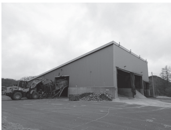
老朽化したおが粉施設
