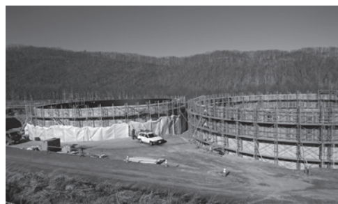
建設中のバイオガスプラント
