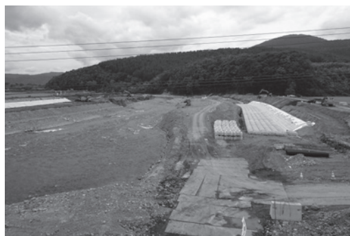
南富良野町で進む護岸工事
