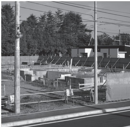
工事中の公住
