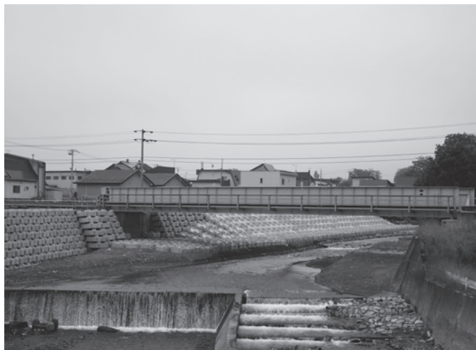
新得町の復旧された鉄橋
