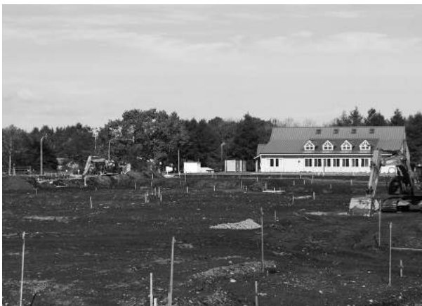
昨年造成中の下幌呂希の杜団地
