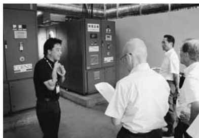
バイオガス発電機
