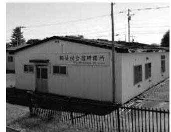
望まれる老朽化対策
