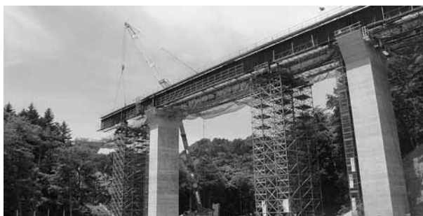
衆音別川橋 写真提供 釧路開発建設部
