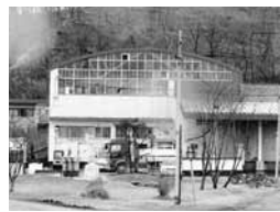
老朽化した「と畜場」
