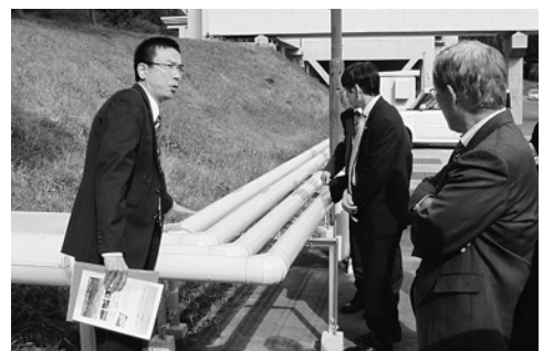
排水熱利用ヒートポンプ
