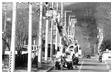
光ファイバ設置工事
