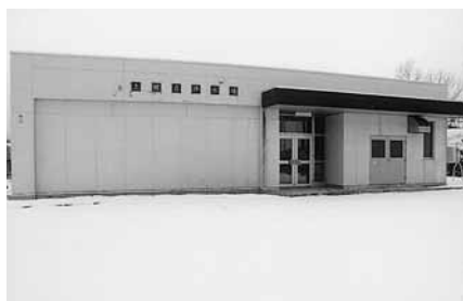
上幌呂浄水場
