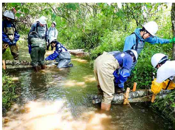
水制工設置の様子
