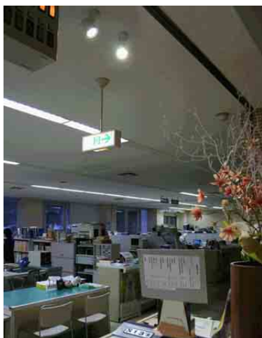
天井に取り付けられた2個のスポットライト。利便性が向上しました。
