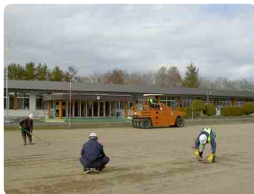
重機を使ったグランド整備の様子
