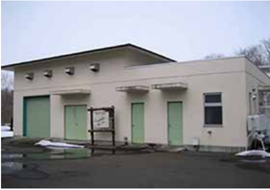
▲鶴居地区農業集落排水処理施設
