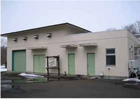
▲鶴居地区農業集落排水処理施設
